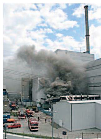
Brand im Kernkraftwerk Krümmel, Sommer 2007
